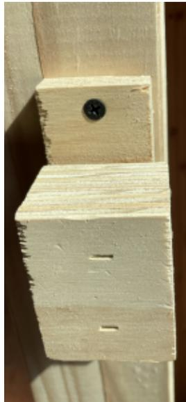
Este conector de desacoplamiento está colocado demasiado lejos de la cara del montante... esto permitirá el contacto entre el enrasado y el montante, lo que eliminará la reducción de ruido.
