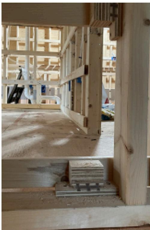
Estas dos fotografías muestran los conectores de desacoplamiento montados en la placa inferior que sostiene el soporte del zócalo.
