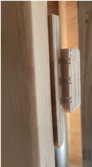
Este conector de desacoplamiento se coloca ligeramente delante de la cara del montante, lo que garantiza que no haya contacto entre el enrasado y la cara del montante.
