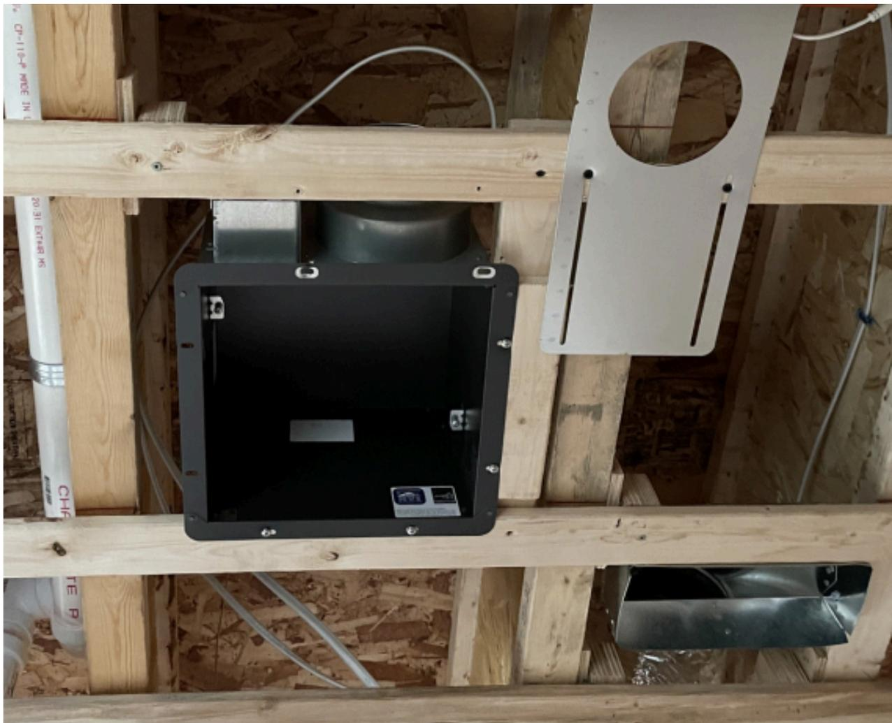
Preinstalaciones de cajas de altavoces, cajas de conexiones de alarmas contra incendios, latas de iluminación... Todo se fija al entablado desacoplado.
