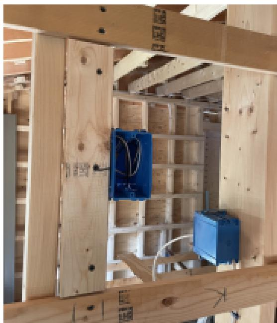
En esta foto del lado no desacoplado de este muro, se puede ver la sección de 2x4 añadida detrás, que conecta las dos filas de listones, de modo que la sección añadida coincida con el plano frontal de las filas de listones. La otra caja eléctrica a la vista está fijada directamente al montante de este lado, el no desacoplado del muro.
